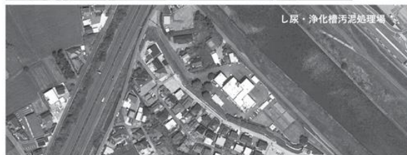
現在、下水・し尿等の処理は別組織、別の場所で行われている
