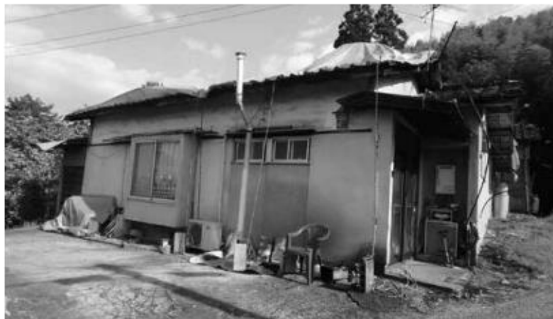
老朽化した町営住宅（牛ヶ瀬団地）
