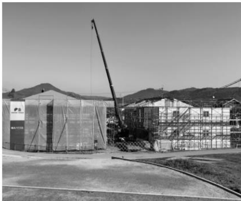
建設が進む災害公営住宅（1丁目II期地区）1月17日現在
