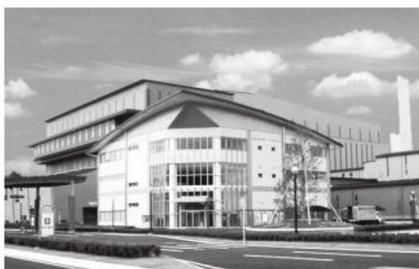
廃棄物処分施設の委員会研修として、11月に訪れる予定の「エコクリーンプラザみやざき」
