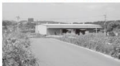
御船竹資源開発(株)建設予定地の現状 すでに、御船竹資源開発(株)と関係のない 会社の建物がある
