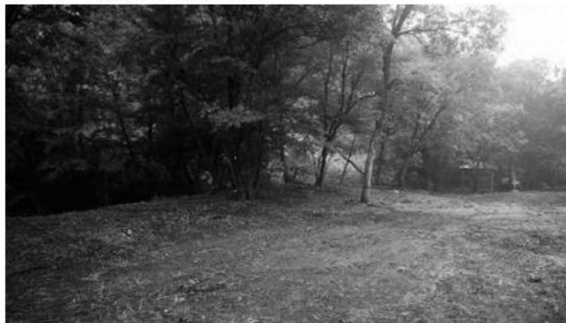
旧のんびり村ではすでに工事が始まっている（県や町に無断で木々が伐採された区域）
