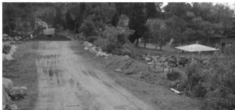
一部ではすでに工事が始まっている
